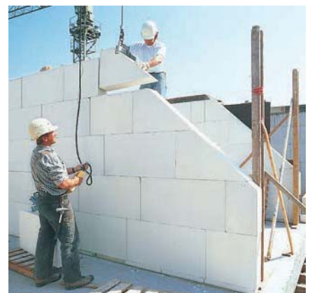
KS-Planelemente lassen sich optimal von Zwei-Mann-Teams verarbeiten.
