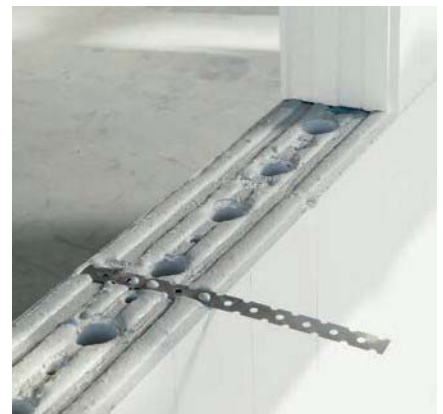
Lagerfuge vollflächig vermörtelt mit eingelegtem Edelstahlfachanker.
