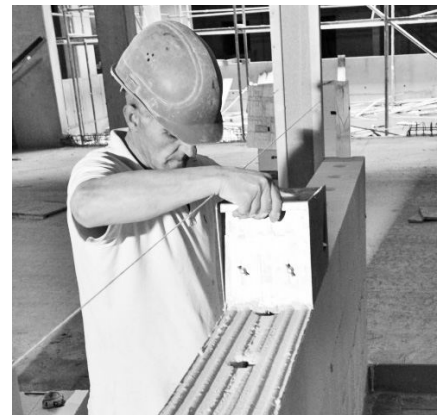
Der Einsatz des Mörtelschlittens spart Zeit, reduziert die Mörtelverluste, sorgt für eine gleichmäßige und vollflächige Mörtelschicht.
