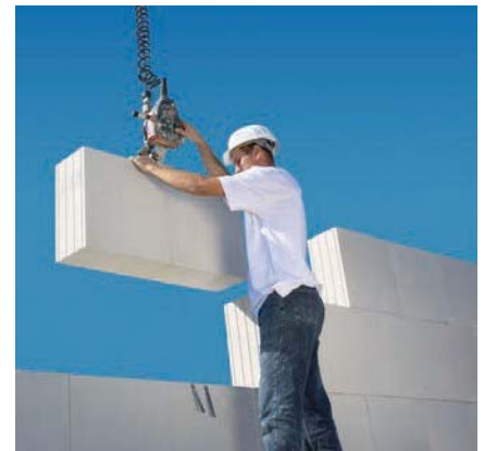
Das „Ein-Mann-Mauern“ ist eine spezielle Versetztechnik, bei der nur ein Maurer je Arbeitsplatz im Einsatz ist.
