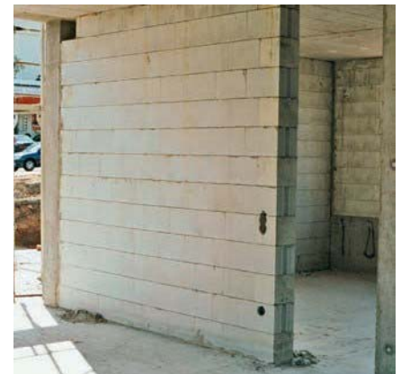
Längenausgleich grundsätzlich am Ende zu Querwänden anordnen.
