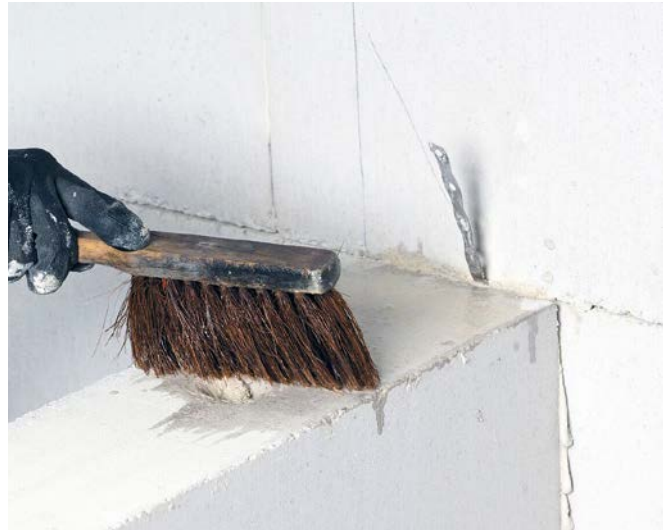
Bild 20 Bei sehr hohen Außentemperaturen sind die Steine vorzunässen
