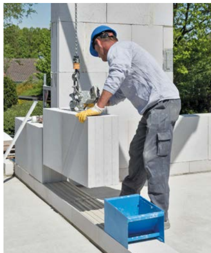
Bild 23 Vermauern von KS XL-Raster-elementen
