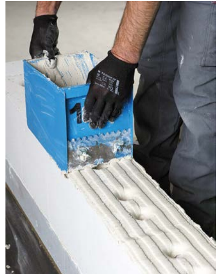
Bild 39 Auftragen des Mörtels für die Lagerfuge
