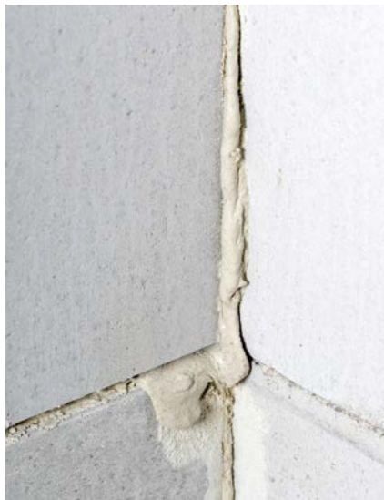
Bild 41 Vollfugiger Stumpfstoßanschluss mit Dünnbettmörtel vor dem Abstreichen
