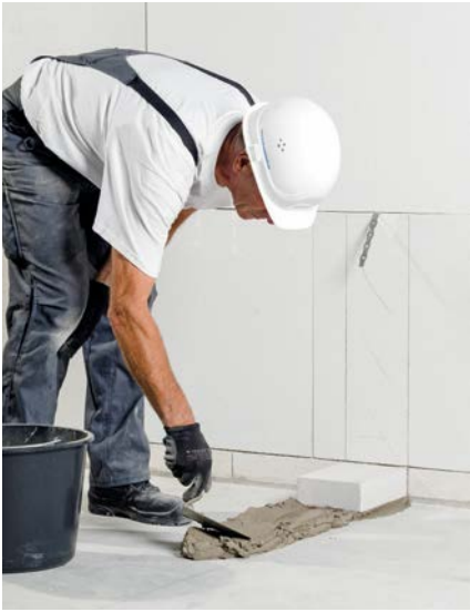
Bild 33 Mörtel auf die Betonsohle auftragen
