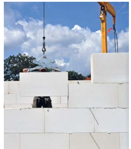
Bild 24 Vermauern von KS XL-Plan-elementen
