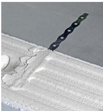
Bild 35 Stumpfstoßtechnik: Mörtelbett mit Edelstahl-Flachanker
