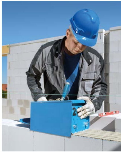
Bild 3 Mörtelauftrag mit Mörtelschlitzen
