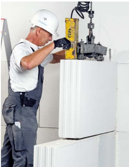
Bild 40 Versetzen eines XL-Elements
