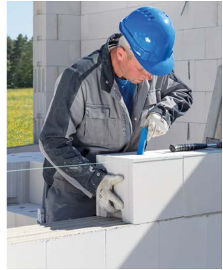
Bild 4 Versetzen von KS -R-Plansteinen in Dünnbettmörtel
