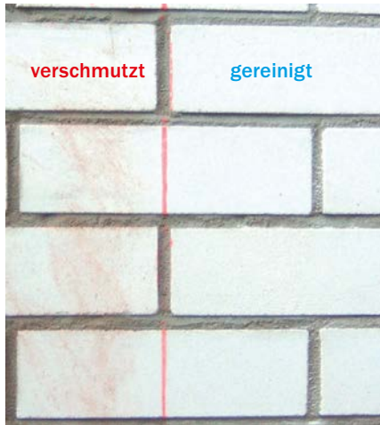
Bild 12 Reinigungseffekt, Beispiel Reinigung mit Schleifpapier, Körnung 140
