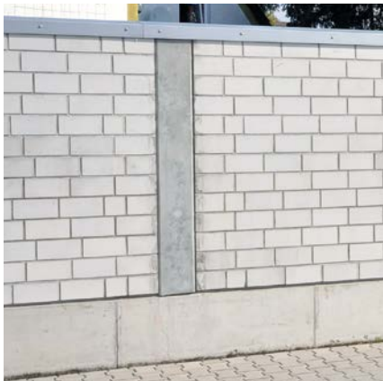
Bild 50 Frei stehende KS-Wand mit Aussteifungen
