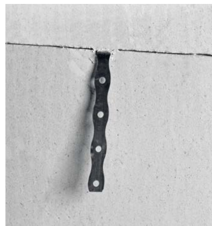
Bild 36 Stumpfstoßtechnik: Abgewinkelte Edelstahl-Flachanker (Bauphase) in Achse der anschließenden Wand
