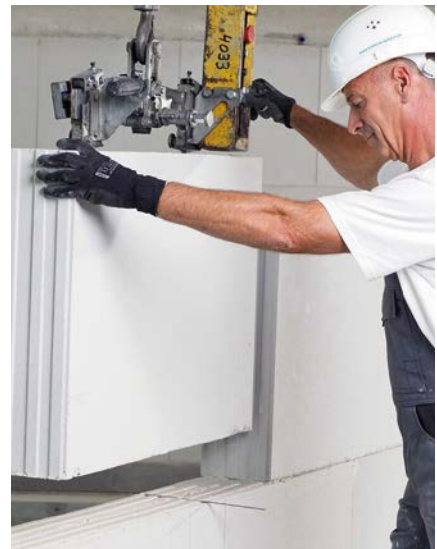
Bild 42 Versetzen der folgenden Elemente
