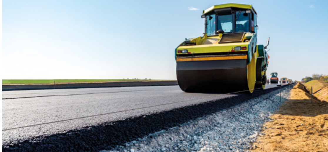
Kalksandstein-Rezyklate können auch im Straße- und Wegebau eingesetzt werden und tragen dadurch zur Ressourcenschonung bei.
