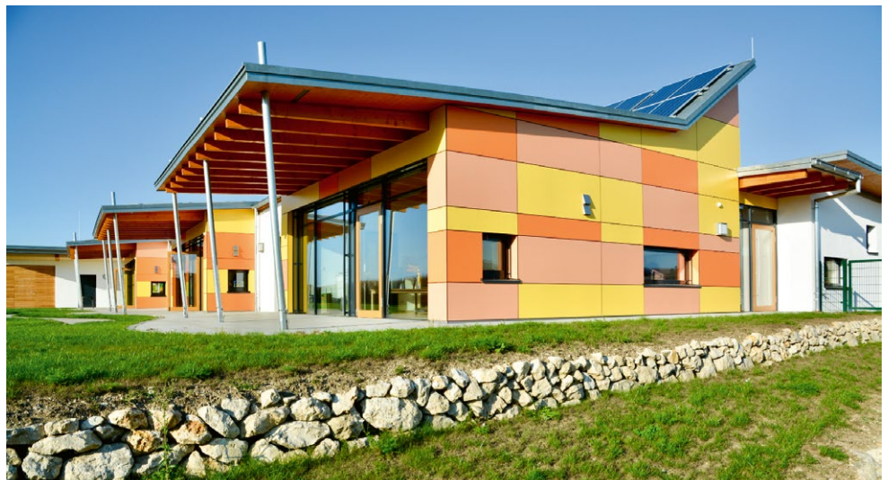
Foto: © Unipor / Architekturbüro Finsterer
