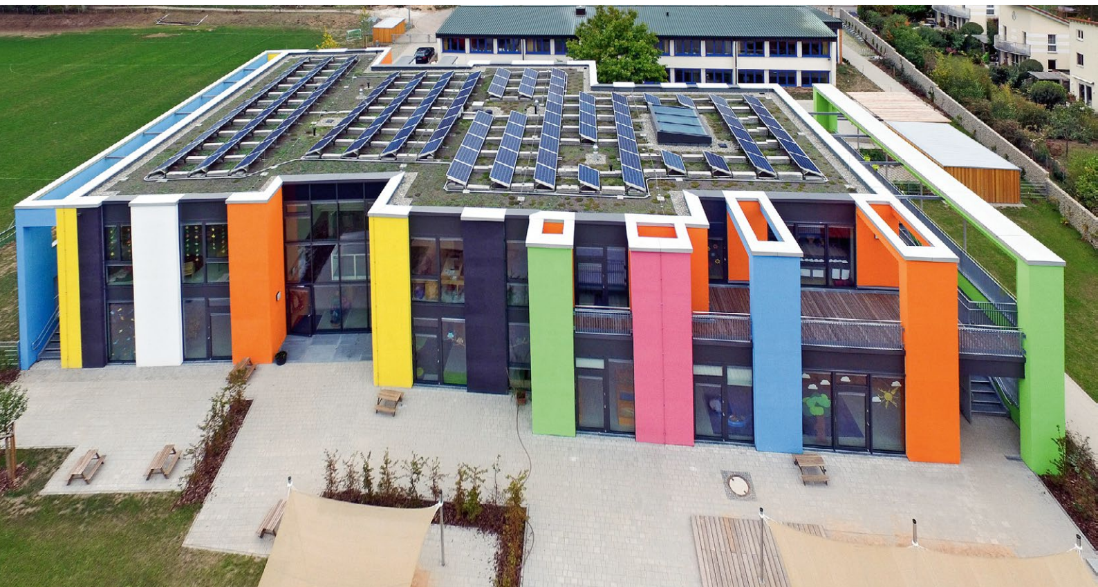
Eine Kombination für die Zukunft: Massivmauerwerk und die Photovoltaikanlage auf dem Dach.
