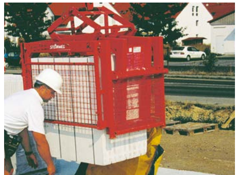
Bild 15 Absetzen der Steinpakete mit dem Baustellenkran auf der Zwischendecke
