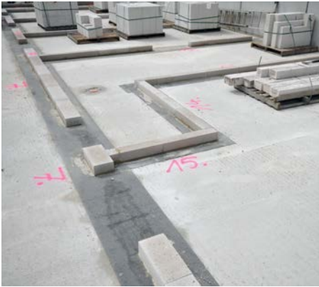
Bild 10 Das Anlegen der Kimmschicht erfolgt mit zeitlichem Vorlauf.
