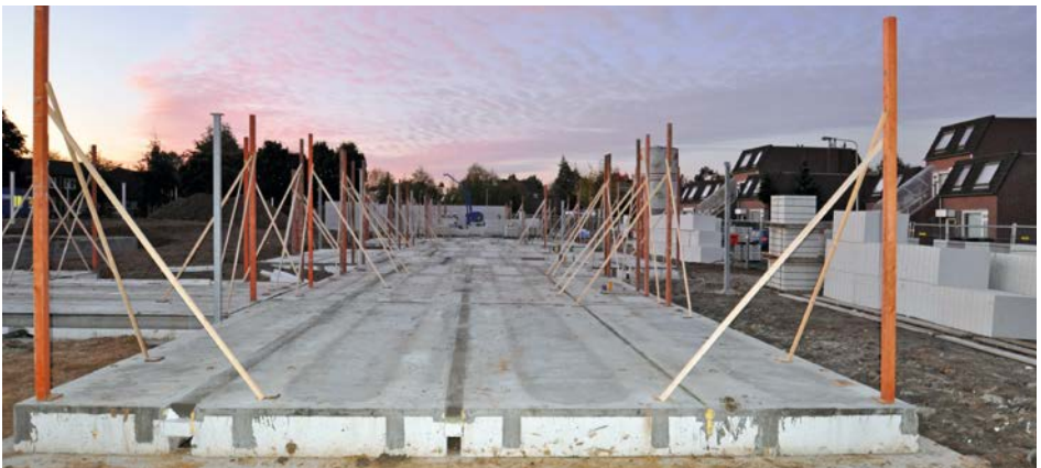
Bild 1 Das sorgfältige Aufstellen der Mauerlehren erfolgt vor Beginn der Mauerarbeiten.
