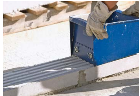
Bild 3 Der Dünnbettmörtel wird mit dem Mörtelschlitten und der vom Dünnbettmörtel-Hersteller empfohlenen Zahnschiene aufgetragen.
