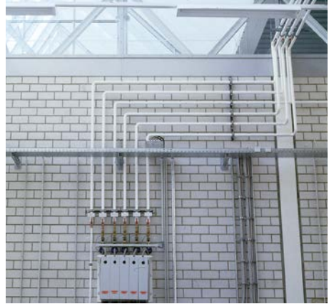
Bild 11 Innensichtmauerwerk aus Kalksandstein mit befestigten Installationsleitungen
