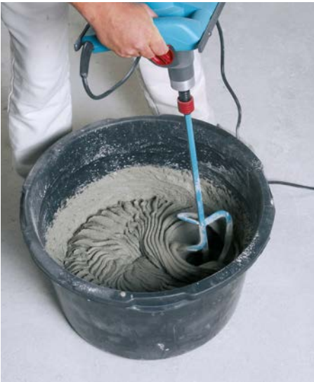
Bild 14 Der Mörtel wird nach Verarbeitungsanweisung gleichmäßig durchgemischt.
