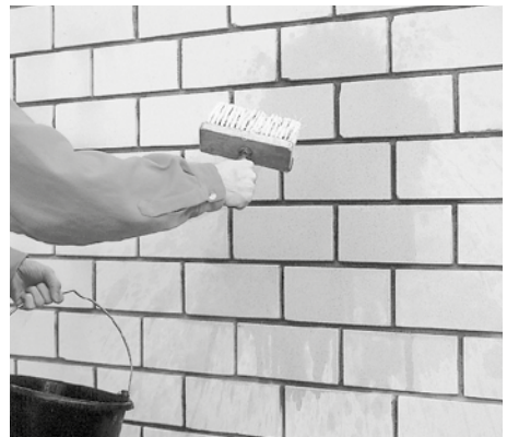
Bild 32 Das Fugennetz ist gründlich vorzunässen, um das „Verdursten“ des Fugenmörtels zu vermeiden.
