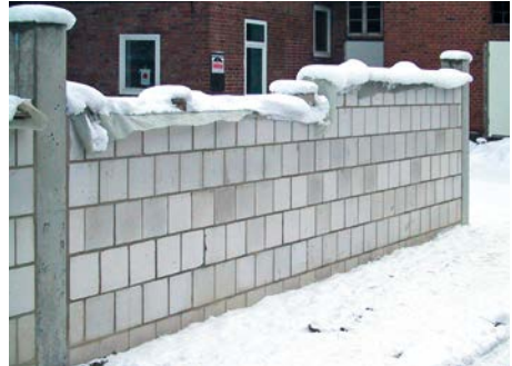
Bild 26 Das frische Mauerwerk ist vor Frost zu schützen, z.B. durch Abdecken mit Folie.
