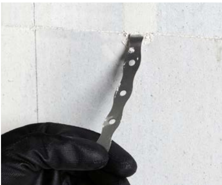
Bild 53 Vor dem Aufmauern der Querwand wird der Edelstahl-Flachanker aufgebogen.
