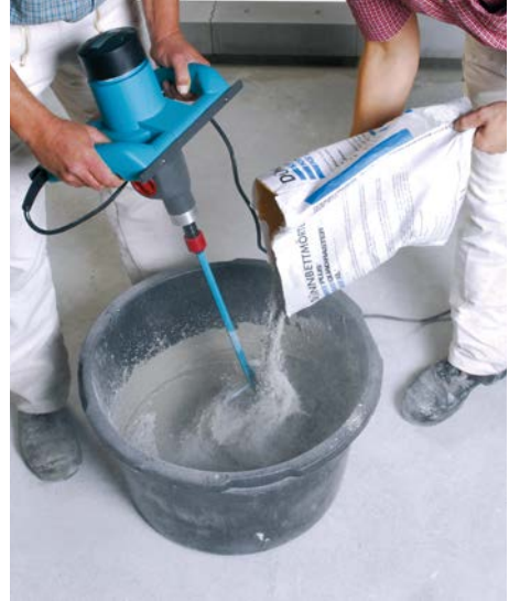
Bild 13 Der Werkmörtel wird in den Maurerkübel eingestreut.
