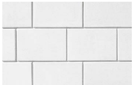
Bild 13 Sichtmauerwerk aus KS-Fasensteinen, außen in Verblenderqualität und mit vermörtelten Stoßfugen
