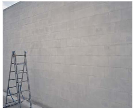
Bild 8 Geschlämmtes KS-Mauerwerk mit KS-Plansteinen
