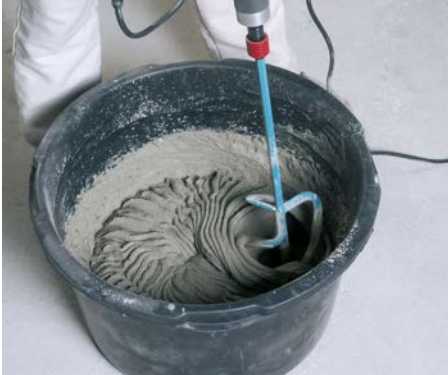
Bild 4 Der Dünnbettmörtel wird nach Herstellerangaben angemischt und nach vorgegebener „Reifezeit“ weiterverarbeitet.
