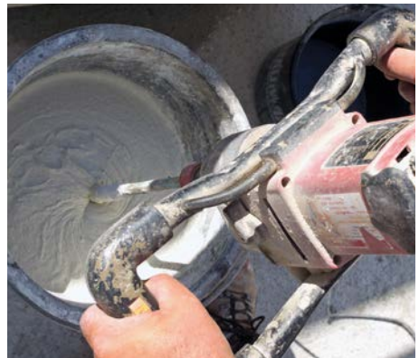
Bild 1 Anmischen von Dünnbettmörtel
