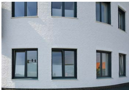
Bild 1 Kalksandsteine verleihen dem Haus eine besondere Optik.
