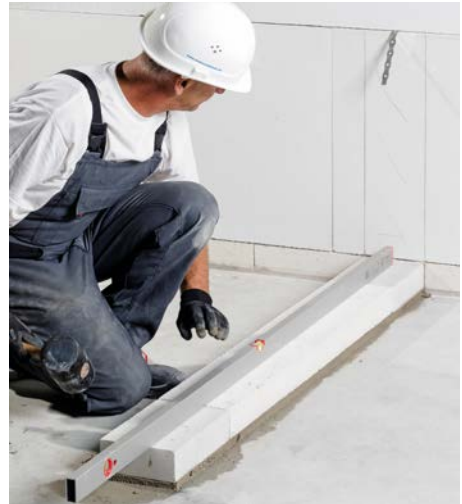
Bild 9 Kimmsteine in Längsrichtung ausrichten
