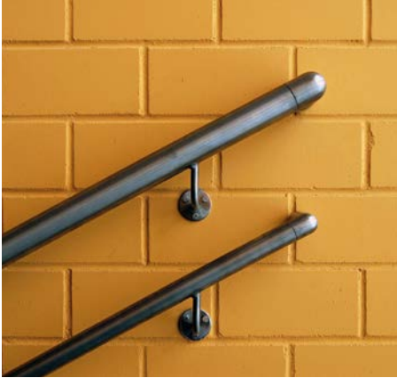
Bild 10 Befestigung von Treppengeländern an KS-Mauerwerk
