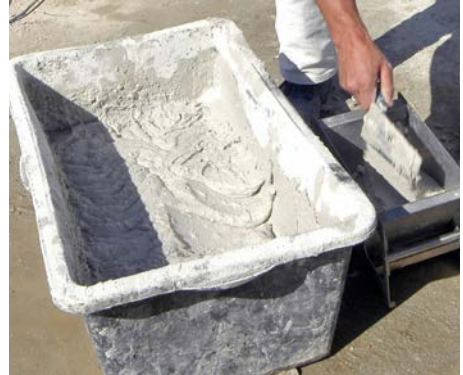
Bild 5 Der Dünnbettmörtel wird in den Mörtelschlitten eingefüllt.
