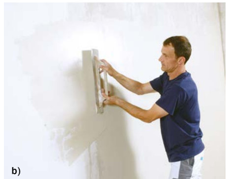
Bild 9 Arbeitsschritte beim Verputzen einer Wand; a) Auftrag des Putzmörtels; b) Glätten der Putzoberfläche
