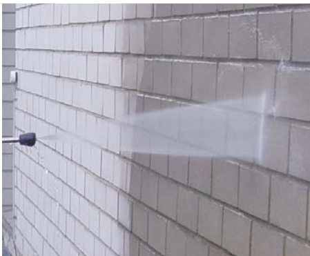
Bild 36 Reinigung mit Dampfstrahlgerät
