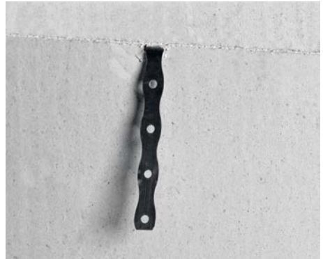
Bild 52 Aus Gründen der Arbeitssicherheit wird der hervorstehende Teil der Edelstahl-Flachanker abgewinkelt.
