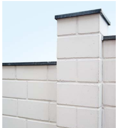
Bild 27 Gemauerter Pfeiler aus KS-Verblendern
