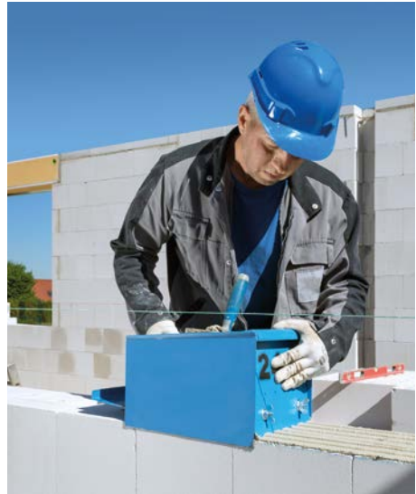
Bild 17 Der Dünnbettmörtelauftrag erfolgt einfach und schnell mit dem Mörtelschlitten.
