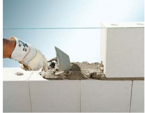
Bild 4 Verarbeitung von Normalmauermörtel
