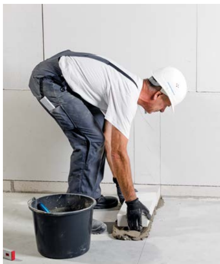
Bild 8 Kimmsteine ins Mörtelbett verlegen
