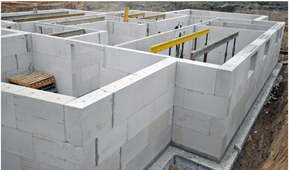
Bild 5 Keller, aus KS XL-Elementen erstellt
