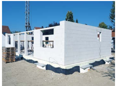
Bild 8 Eine aufgeräumte Baustelle ist die beste Werbung.
