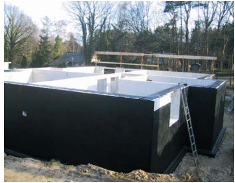
Bild 3 Kellerwand-Außenseite mit PMBC-Abdichtung
