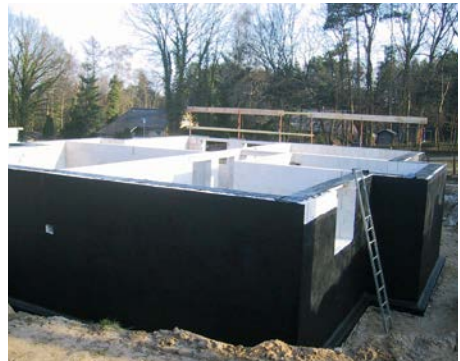
Bild 10 Kellerwand-Außenseite mit PMBC-Abdichtung
