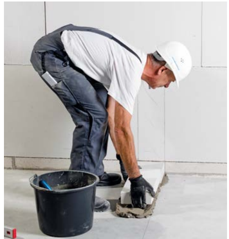
Bild 7 Kimmstein ins Mörtelbett verlegen
