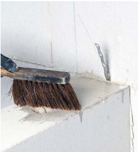
Bild 6 Bei hohen Außentemperaturen sind die Steine vorzunässen.
