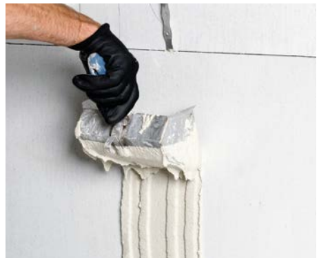
Bild 54 Für das Aufmauern der Querwand wird für den Stumpfstoß Dünnbettmörtel aufgezogen.
