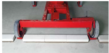
Bild 10 In der Kimmsschicht sind ggf. Lücken für das Versetzgerät frei zu lassen.
