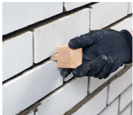
Bild 29 Auskratzen der Fugen mit einem Holzbrettchen
