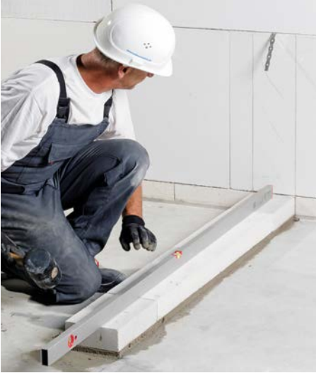
Bild 10 Kimmsteine in Längsrichtung ausrichten
