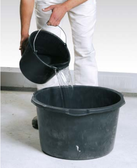
Bild 12 Die Wassermenge wird gemäß der Verarbeitungsanweisung zuerst eingefüllt.
