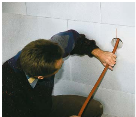
Bild 6 Einziehen eines Leerrohres
