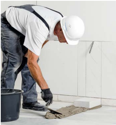
Bild 6 Mörtel auf die Betonsohle auftragen
