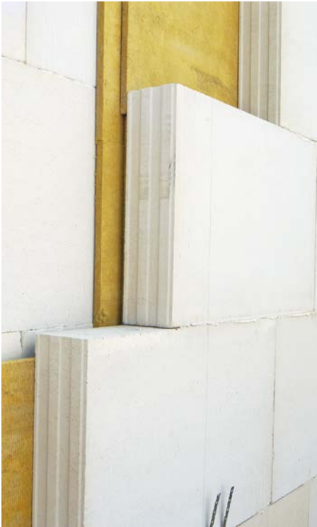
Bild 47 Dicht gestoßene Mineralfaserplatten Typ WTH vermeiden Schallbrücken.
