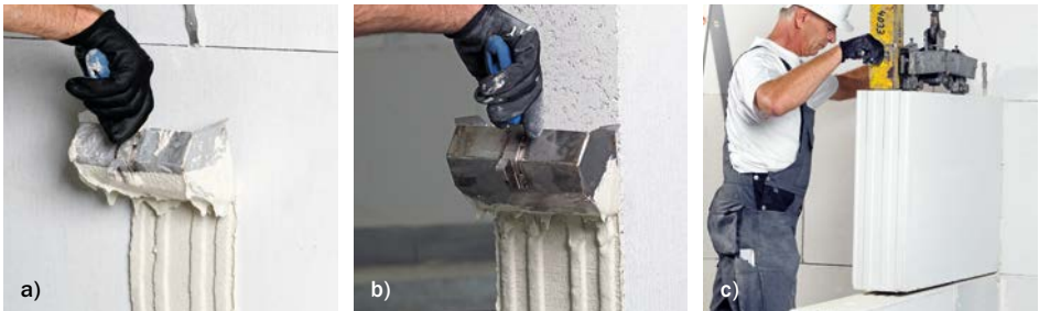
Bild 19 Mörtel der Anschlussfuge mit der Stoßfugenkelle sowohl auf die Wand als auch auf die KS XL-Stirnseite auftragen, dann das KS XL-Element versetzen und dabei fest an die vorhandene Wand andrücken.
