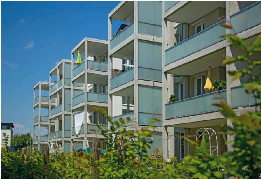
Die Balkone stehen thermisch getrennt vor der Südfassade.
