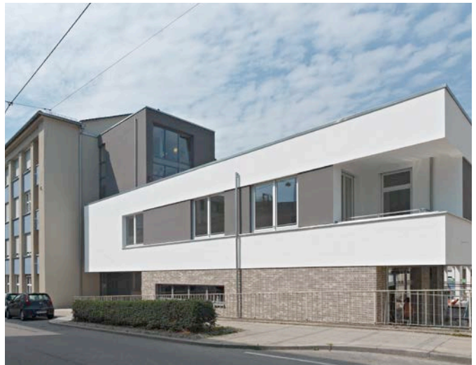
Kalksandstein mit WDVS und Klinkerriemchen im Sockelbereich
