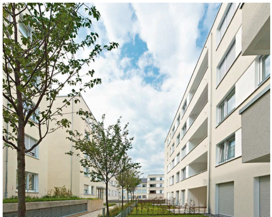
Erdgeschosswohnungen mit privaten Grünflächen
