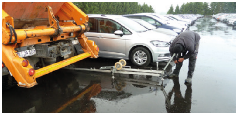
Der Einsatz von KS-Recycling-Material im Straßenbau – Messung der Durchbiegung einer Straßenfläche unter Schwerlast (AiF-Nr.: 19889).
