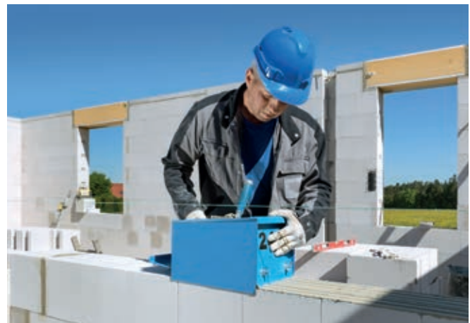
Bild 23 Aufziehen des Lagerfugenmörtels mit dem Mörtelschlitten
