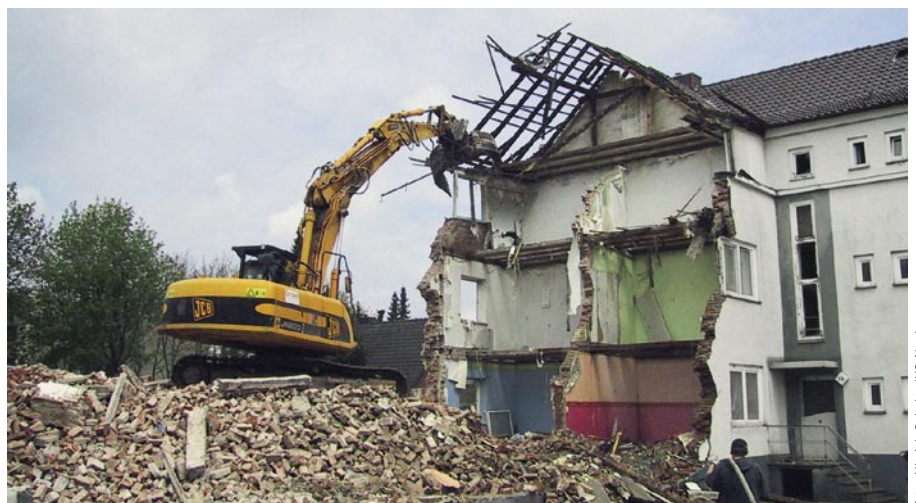
Abriss der Bestandsgebäude
