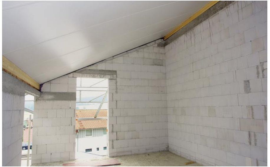
IQ++: Rohbau innen
