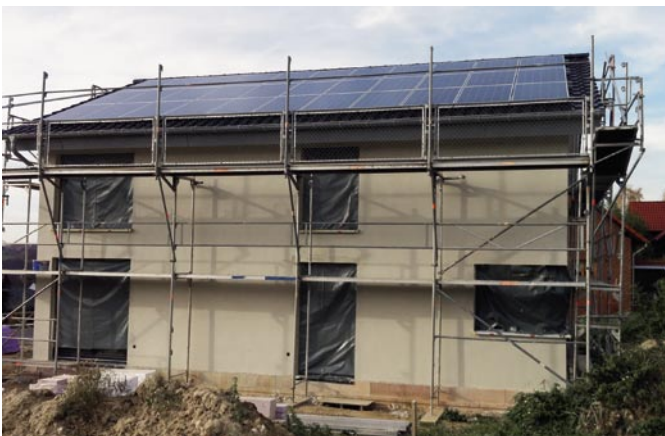
IQ++Energiespeicherhaus, Seitenansicht eingerüstet
