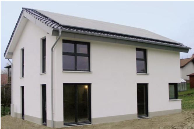
IQ++Energiespeicherhaus in Körle
