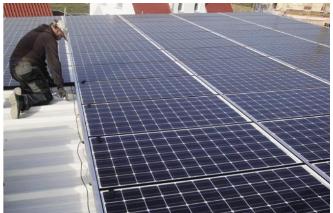
Passivhaus in Erlangen: Montage der Photovoltaikanlage
