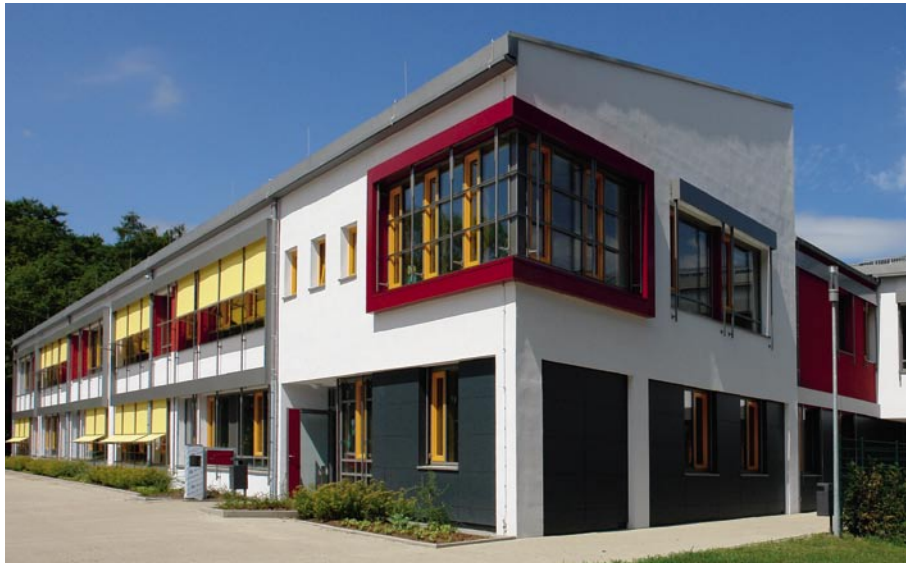
Beispiel Plusenergie-Schule: Herman-Nohl-Schule in Osnabrück, ReindersArchitekten BDA, Osnabrück
