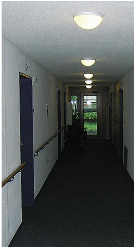
Bild 12: Flur mit unzureichender Beleuchtung
