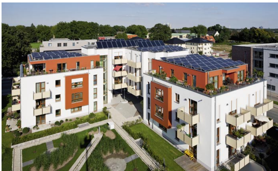
Südansicht des dreigliedrigen Baukörpers, auf dem Dach PV- und Solarthermie-Module
